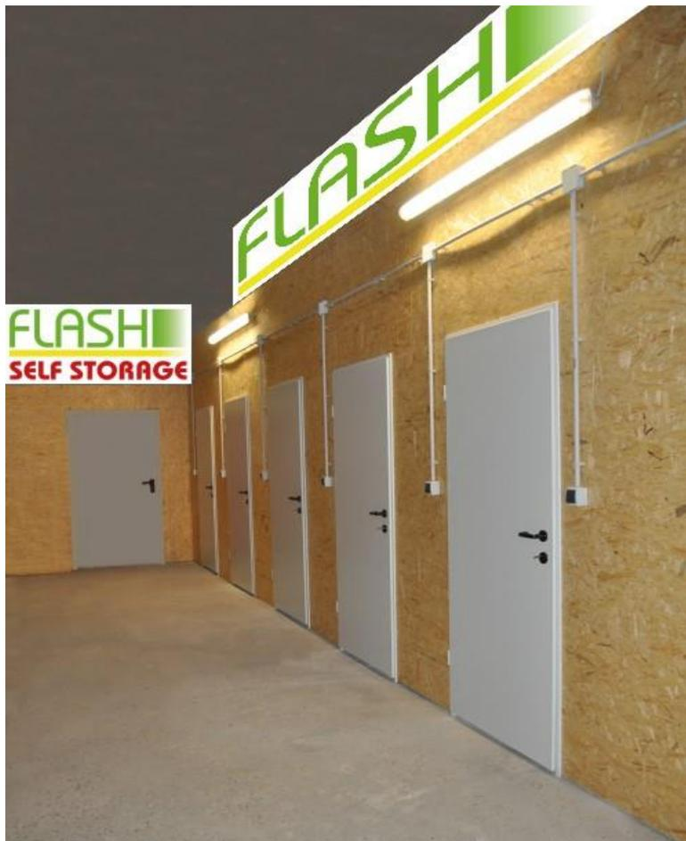
Die Lagerabteile sind mit Sperrholz (OSB) verkleidet und für keine schweren Wandmontagen geeignet, absolute Frostsicherheit ist durch fachgerecht isolierte Lagerabteile und integrierte Frostwächter gewährleistet!
